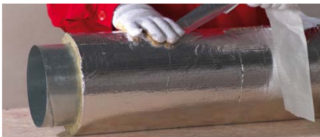
Uszczelnienie taśmą aluminiową połączeń podłużnych i poprzecznych.
