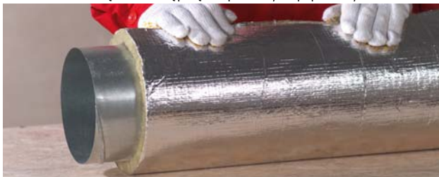
Owiniecie kanału izolacją.
